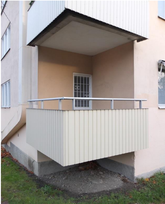
Befintliga balkonger med trapetskorrugerad plåt och aluminiumräcke.
