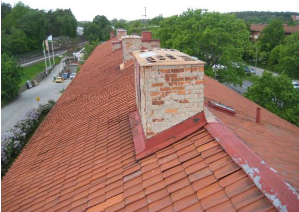
Taket med ursprungligt enkupigt lertegel före omläggningen 2013. Foto från statusbesiktning.
