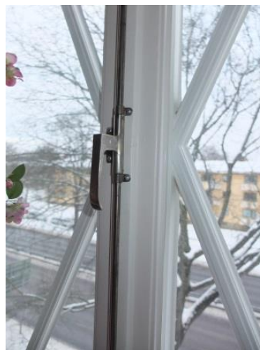
Rombspröjsat fönster med spanjolett.
