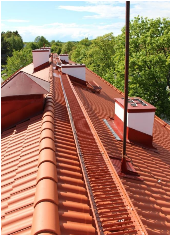
Foto efter omläggningen år 2013. Taket har täckts av tvåkupiga betongpannor, försetts med nockpannor, gångbryggor och plattformar. Skorstenarna har putsats vita. Plåtdetaljerna är röda. Foto Mats Uttervall.
