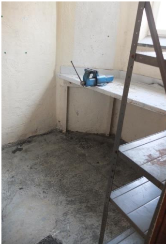
Verkstadslokal i bottenvåningen "portvaktsförråd".
