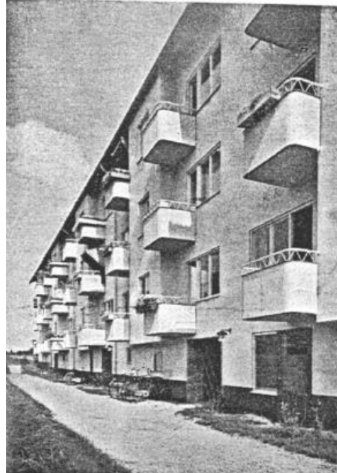
De ursprungliga balkongerna hade fronter av slät sinuskorrugerad plåt, med räcke av rundstål och dekorativt zig-zag-mönster. Grusgång och rabatt framför huset. Odaterat foto ur Stockholms stadsmuseums arkiv.
