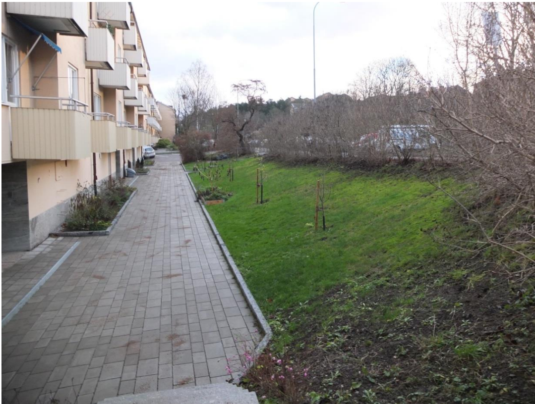
Gården på husets södra sida. Foto mot öster.
