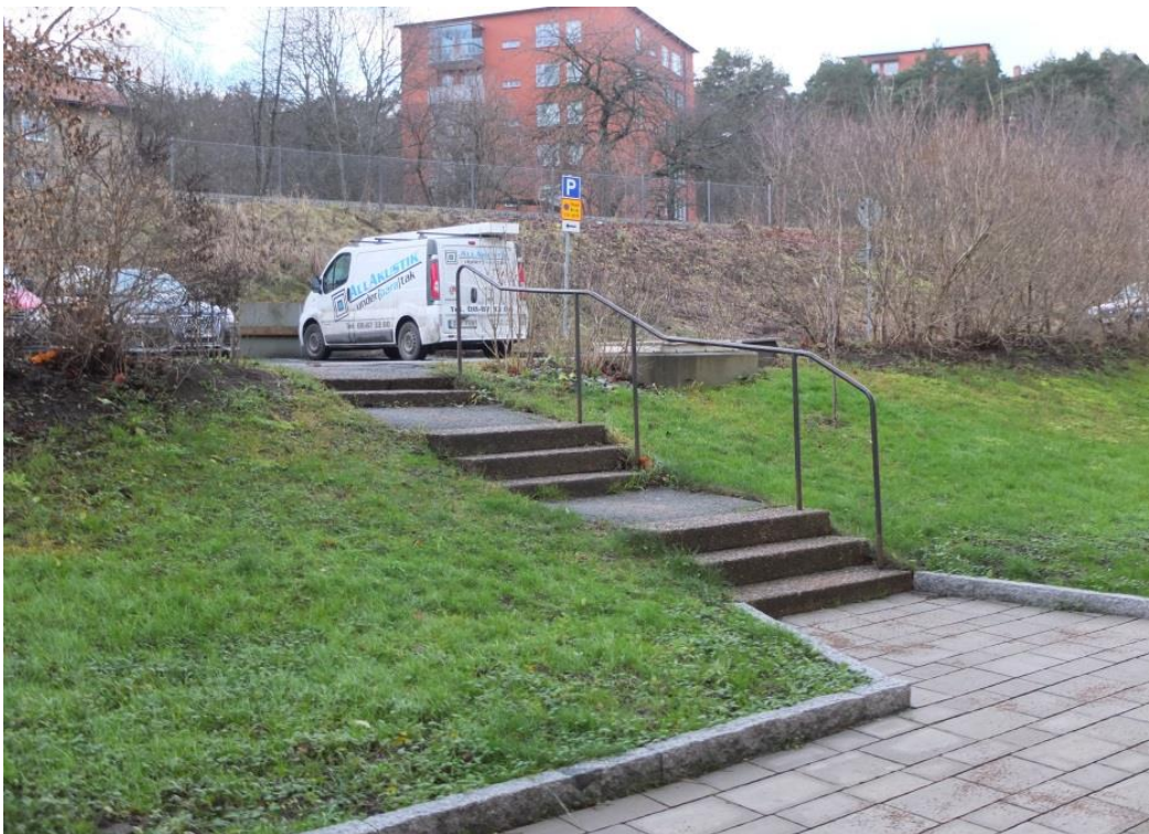
Trappa med räcke av stålror.
