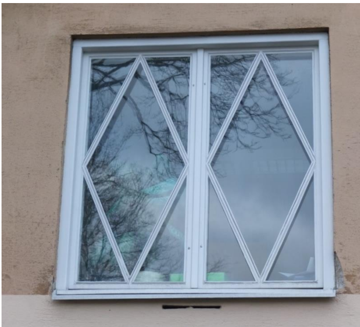
Rombspröjsat fönster mot Drottningholmsvägen som tillhör treornas matplats.
