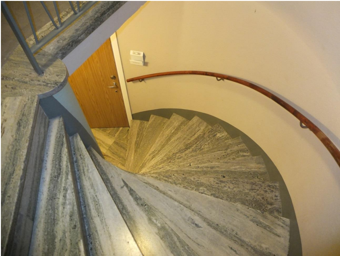
Trapplopp av kolmårdsmarmor. Alla lägenhetsdörrar är utbytta mot säkerhetsdörrar.
