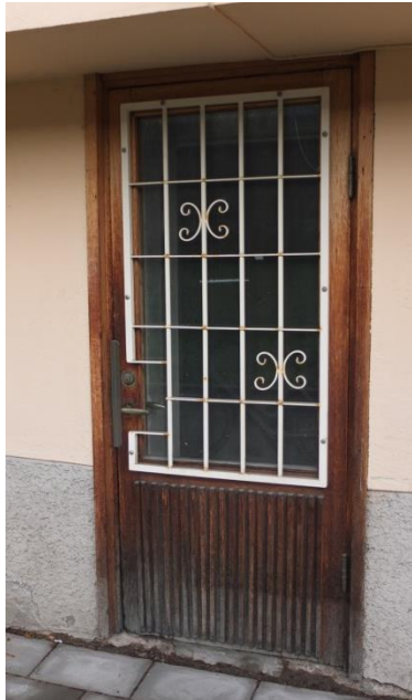
En originaldörr till cykelförrådet med träribbor som sparkskydd. Sekundärt galler.
